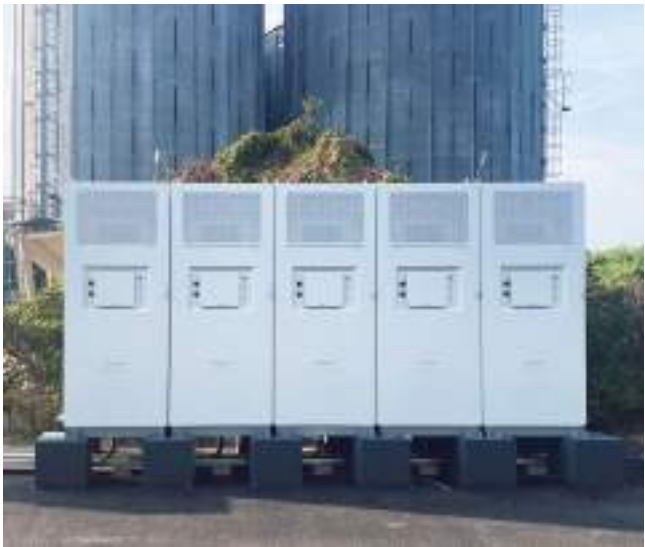
• 匈牙利 DH200Y 500kW/1160kWh 自发自用+光伏消纳
