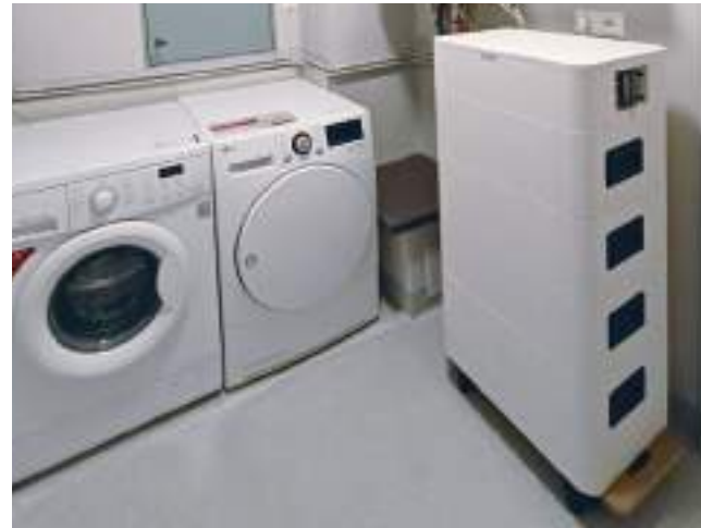
• 14.21kWh Tower T14, 斯里兰卡
