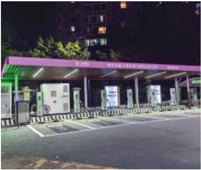
• 中国 DH200F 100kW/215kWh 峰谷套利+削峰填谷
