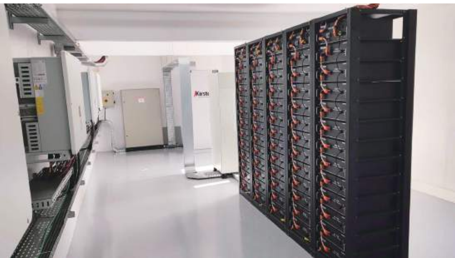
• 巴西 PowerRack HV4 100kW/307kWh 动态扩容 (peak-shaving) + 光伏消纳
