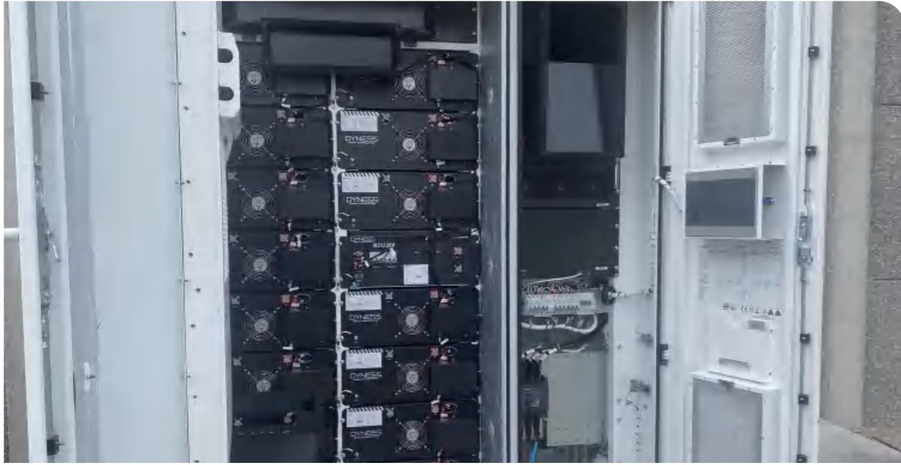
• 比利时 DH200F 100kW/215kWh 动态扩容 (peak-shaving) + 光伏消纳 (自发自用)
